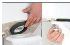
Montáž nádržky k mise
