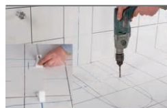
Vyvrtanie otvorov a montáž držiakov (L)
