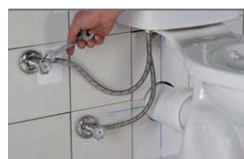
Montáž hadičiek – k ventilom/batérii
