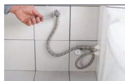
Montáž hadičiek – k ventilom/batérii
