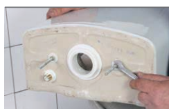
Montáž splachovača
