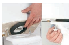
Montáž nádržky k mise
