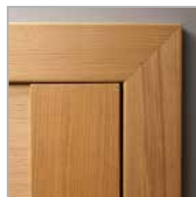
zárubeň DIN DUO, lišty spojované pod úhlem 45°
