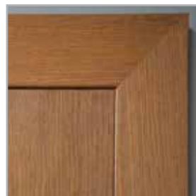
spojování lišt pod úhlem 45°
