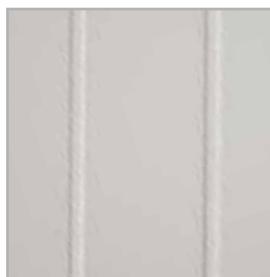
frézování na povrchu křídla
