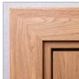
standardní spojování lišt pod úhlem 45°
